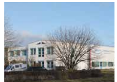
Brugg Rohrsysteme, Wunstorf
